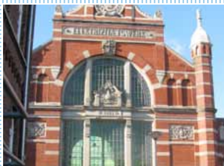
Generatorenhalle in Viersen
